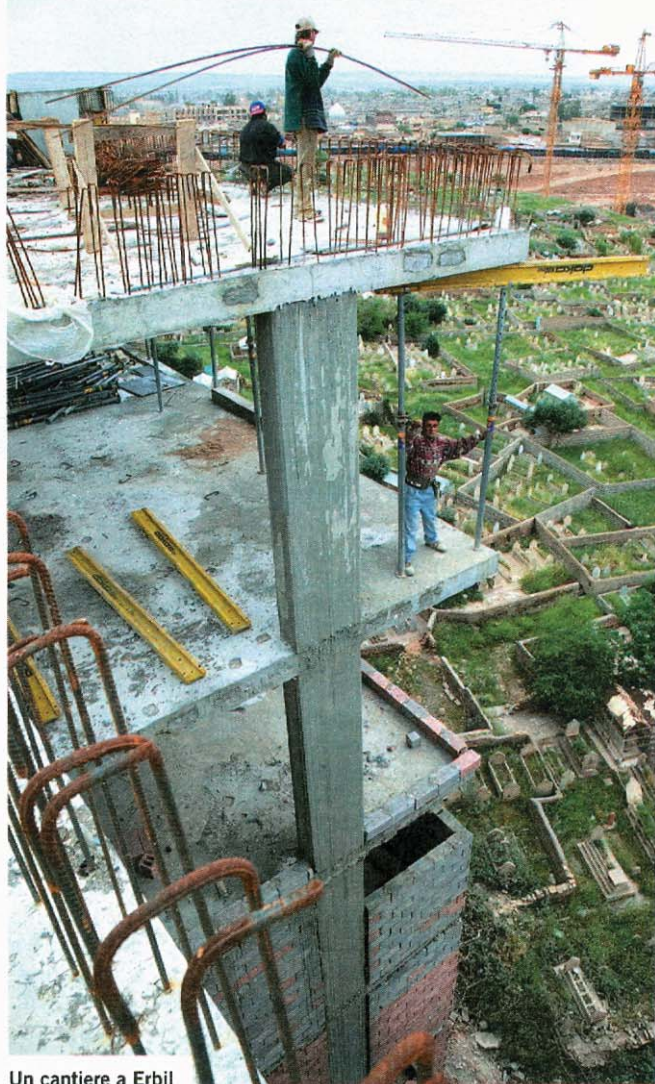
Un cantiere a Erbil
